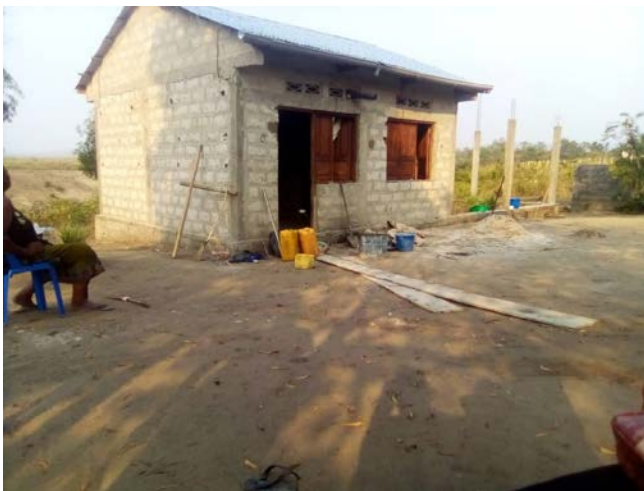
Bouw woning voor enkele van onze weeskinderen
