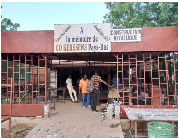
De uitbreiding van de werkplaats voor de lasopleiding is in 2020 voltooid.
