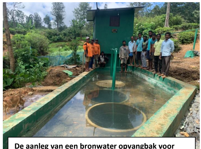
De aanleg van een bronwater opvangbak voor een Tamilschool hoog in de bergen
